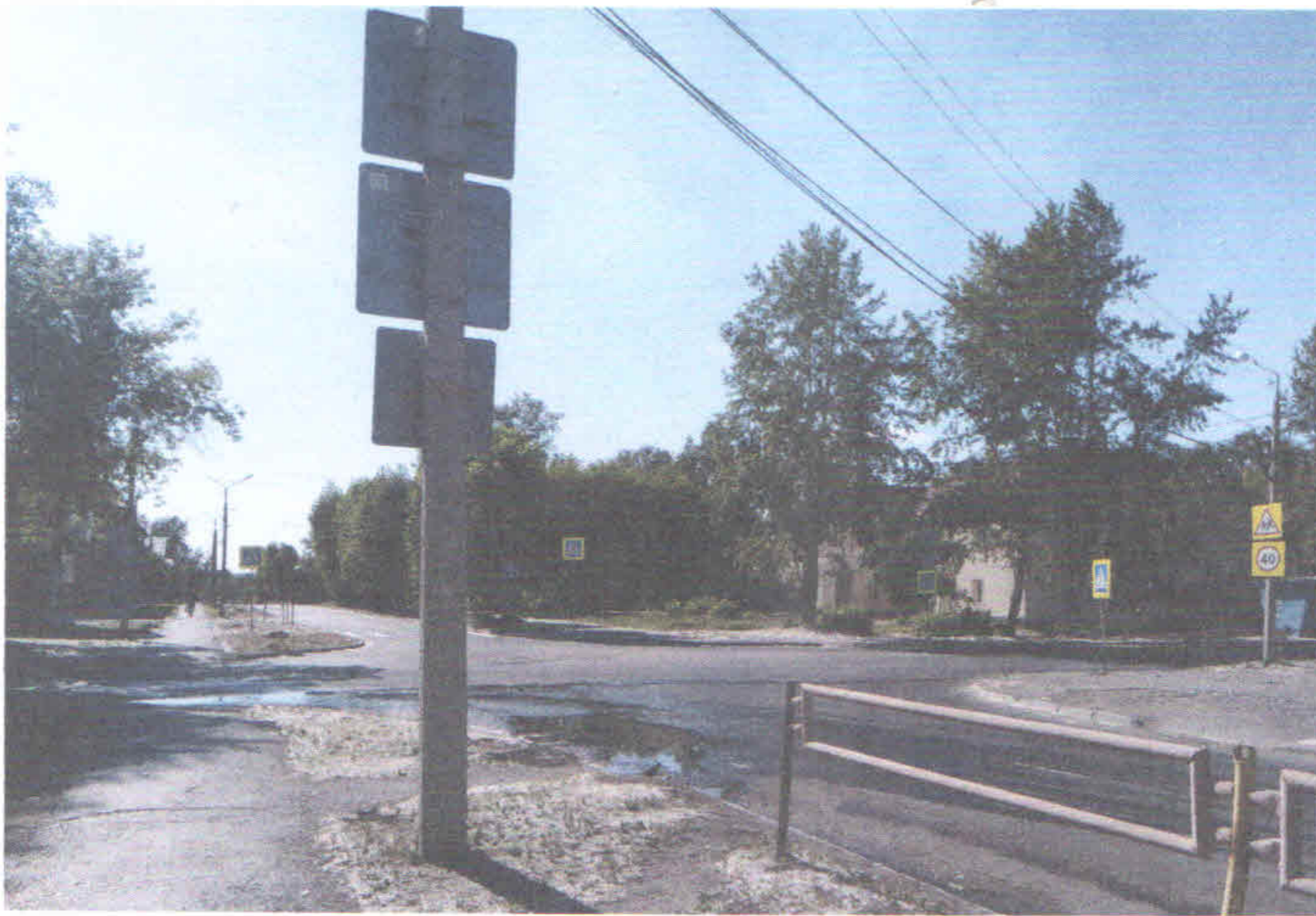
ПЕРЕКРЕСТОК УЛИЦ ВОСТОЧНАЯ И ТРУДОВЫЕ РЕЗЕРВЫ
