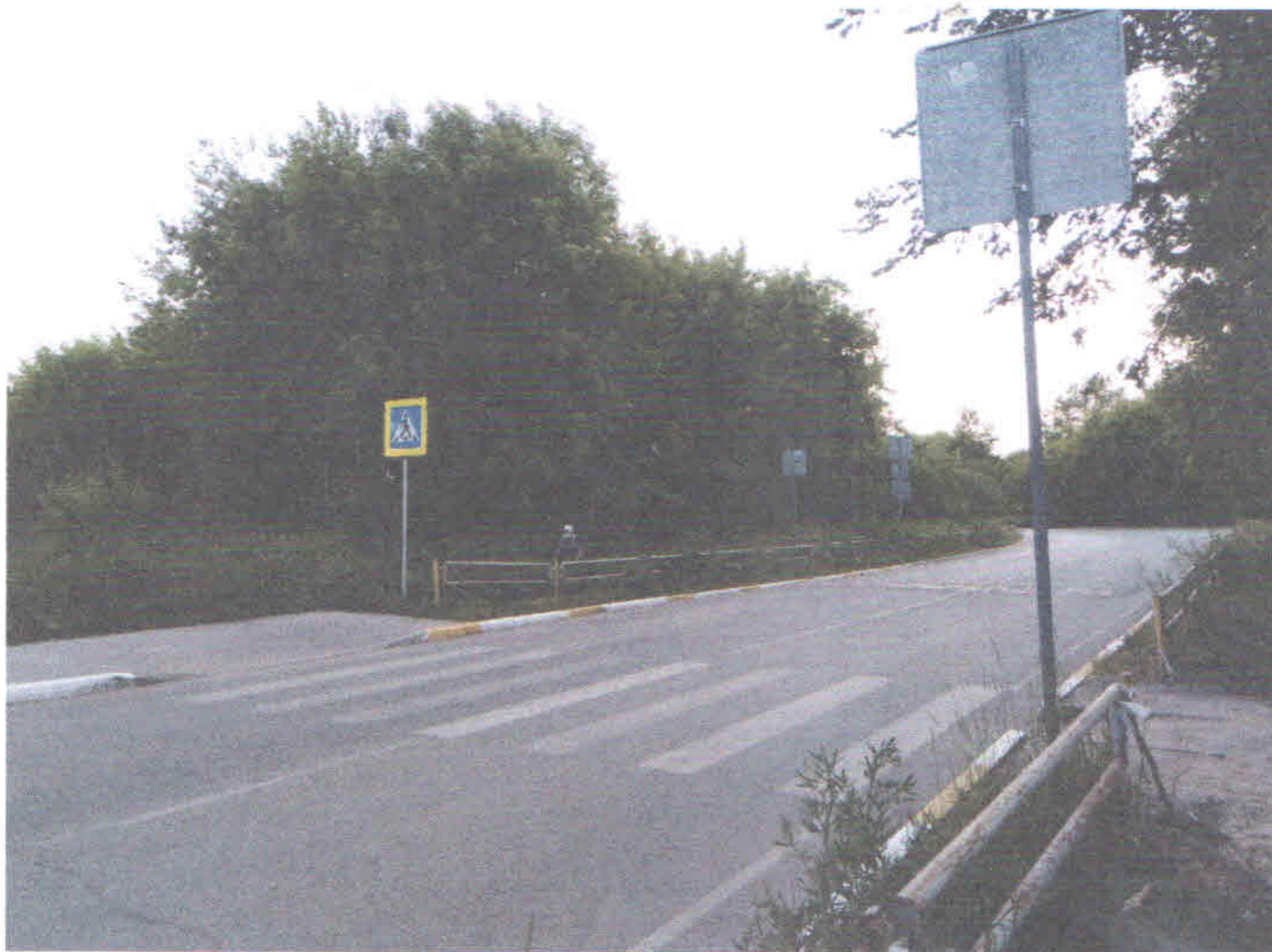
ПЕШЕХОДНЫЙ ПЕРЕХОД НА УЛ. СЛЕСАРЕЙ
